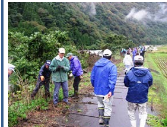
《柵の設置作業》
