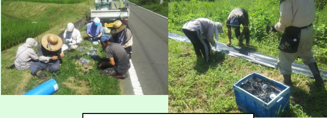
図3 除草シートの設置作業
