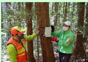
監視システム設置の様子
