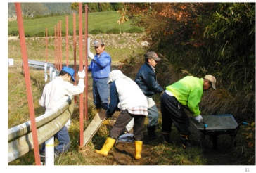
共同作業で柵を設置
