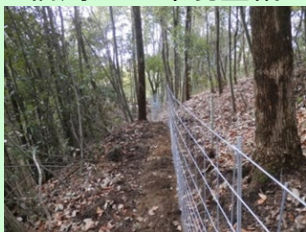
柵周辺の環境整備
