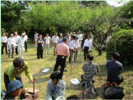
実際に防護柵を設置
