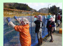
「電落くん」の設置
