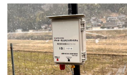
ICT電圧測定器の設置
