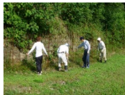
防護柵の追加補修
