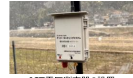
ICT電圧測定器の設置
