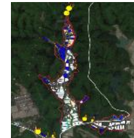
取組後(R5.1)の被害状況
