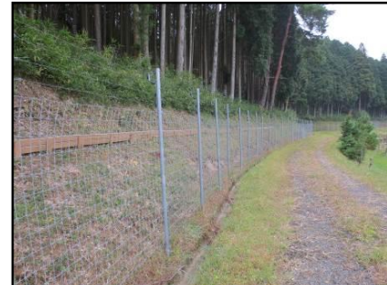
点検によって管理が行き届いた広域恒久柵
