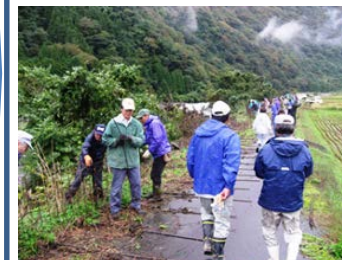
《柵の設置作業》
