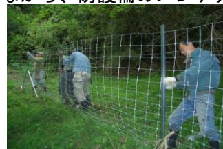
《防護柵の自力施工》
