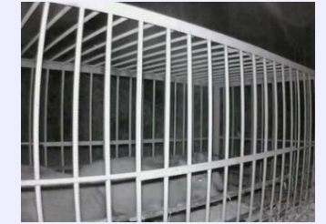
(監視装置作動時写真)
