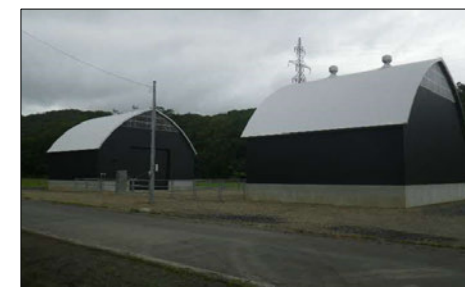
減容化施設の外観
