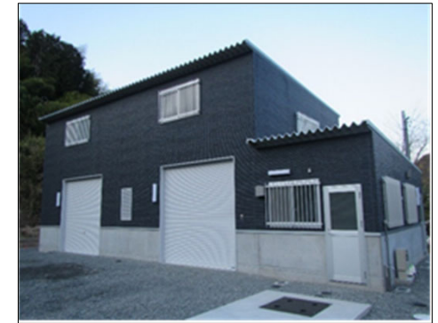
減容化施設の外観
