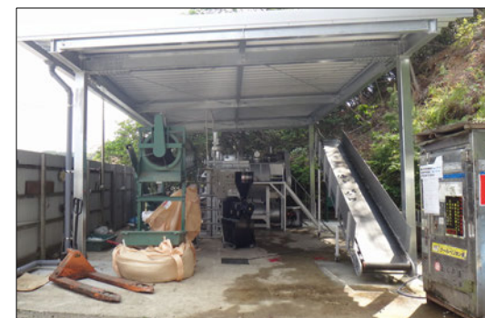
減容化施設の外観
