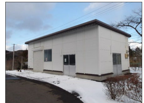
解体処理施設の外観
