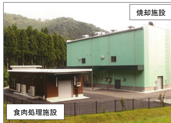
食肉処理施設・焼却施設の外観
