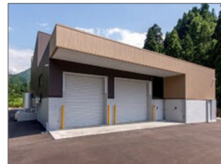
焼却施設の外観
