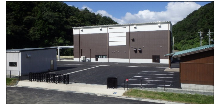
焼却施設の外観
