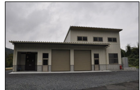
減容化施設の外観
