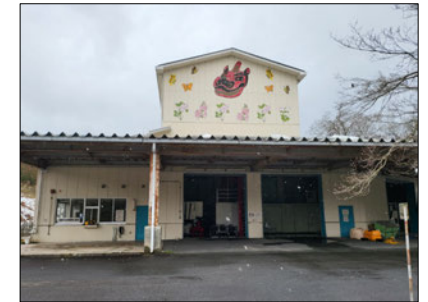
減容化施設の外観
