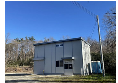
減容化施設の外観
