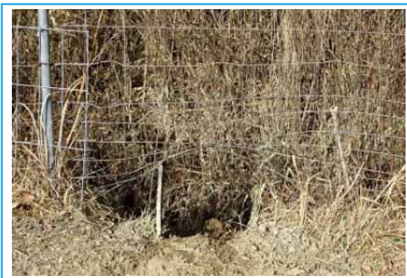
イノシシによる柵下部の損傷
