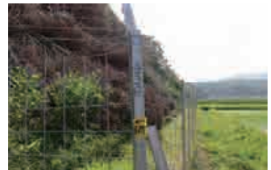
フェンスの支柱に番号をふることで、フェンスの管理作業を分担する際に、効率よく行うことができる
