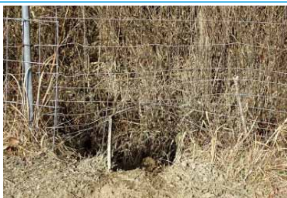
イノシシによる柵下部の損傷
