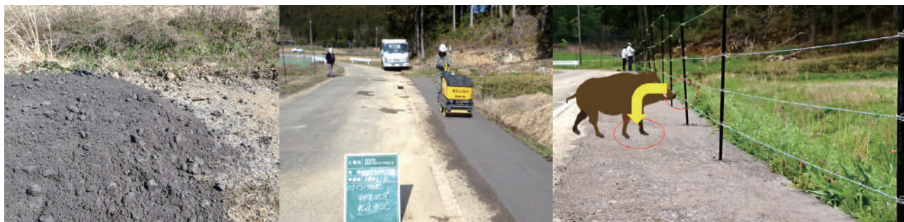
図1 カタマ®SP 舗装の施工と電気柵の融合設置例
