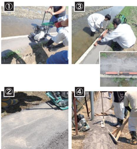
①プレートコンパクターを用いれば簡単に転圧できます。傾斜地などではロープなどで引き揚げながら施工します。
