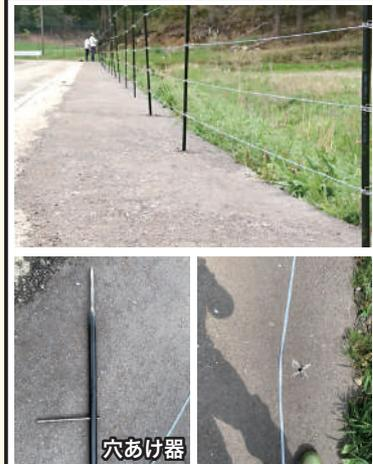
転圧直後に支柱を建てます。硬化してから設置する場合は、尖ったもので穴を開けて支柱を刺します。表面が崩れた場合は、少量のカタマ®SPを再度加水して補強転圧すると修復も簡単にできます。
