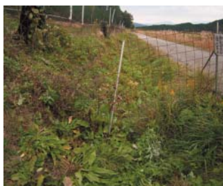
溝をまたぐ所の隙間を防ぐ(メッシュを大きく重ねる)
