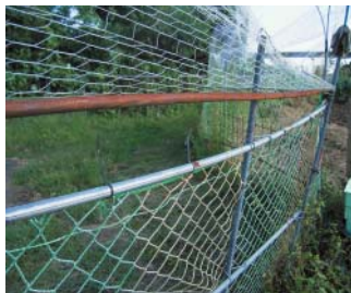
柵の出入り口にできた隙間
