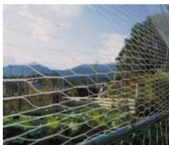
強く張りすぎたネット （網目が水平方向に広がる）
