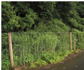
金網フェンス
