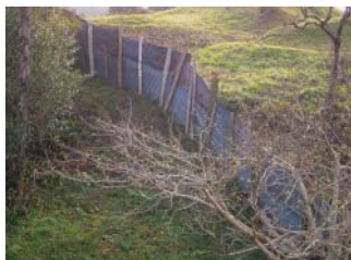
傾斜地で2段に重ねられたトタン板
