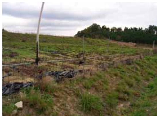
補強パイプを組み込んだ忍び返し柵
