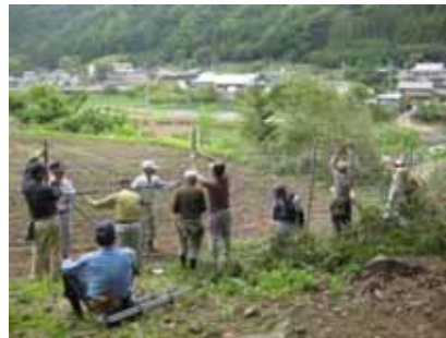
侵入防止柵の設置
