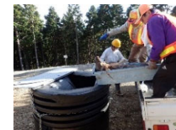
簡易的な埋設設備の整備 （コルゲート管）
