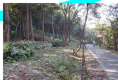
緩衝帯の整備
