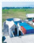
バイオガスプラント
