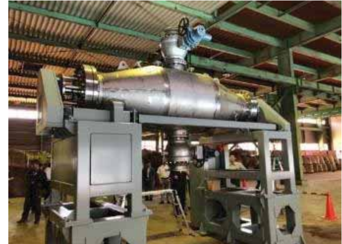
亜臨界水処理装置 (据え付け工事写真)
