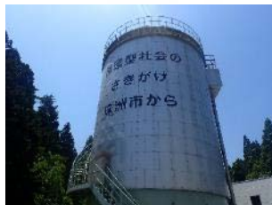
メタン発酵槽
