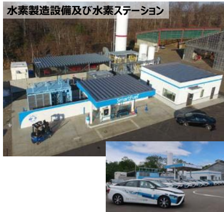
水素製造設備及び水素ステーション
