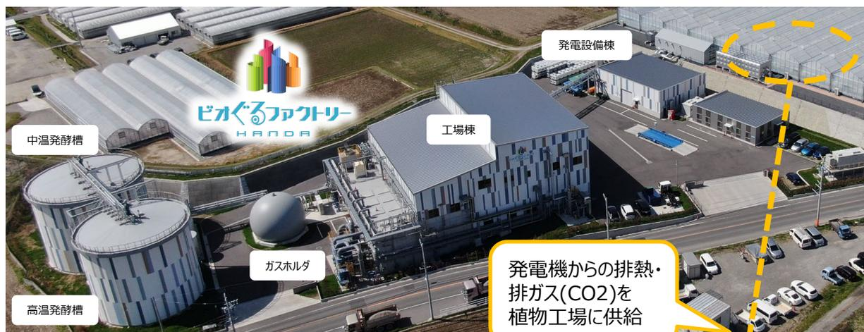
発電機からの排熱・排ガス(CO2)を植物工場に供給
