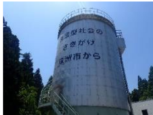
メタン発酵槽
