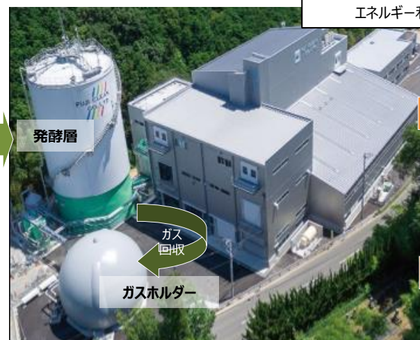
縦型乾式メタン発酵プラント
