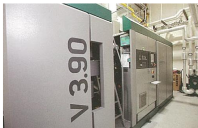
ペレットを不完全燃焼させガス化
