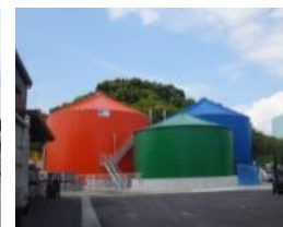
メタン発酵槽・消化液槽
