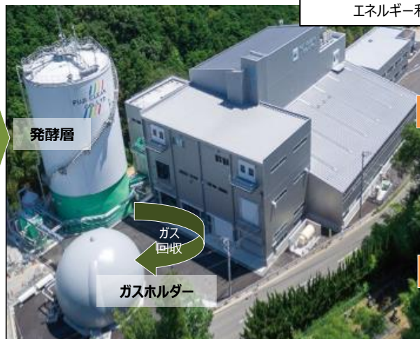
縦型乾式メタン発酵プラント
