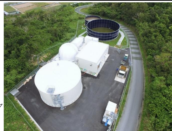
八重瀬町バイオガスプラント
