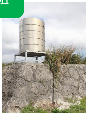
無料で利用できる液肥タンクを設置。
