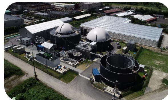
トーヨーバイオメタンガス発電所 発電・発酵残渣の利用のほか、近隣トマトハウスへの熱源供給を行う予定(R4年3月)であり、地域内資源循環に積極的に取り組んでいます。
