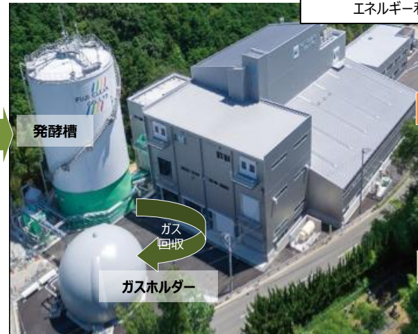
縦型乾式メタン発酵プラント
