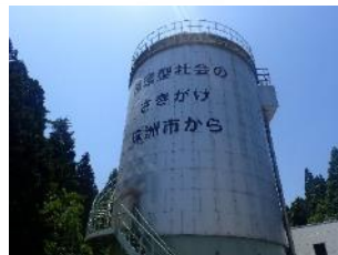
メタン発酵槽
