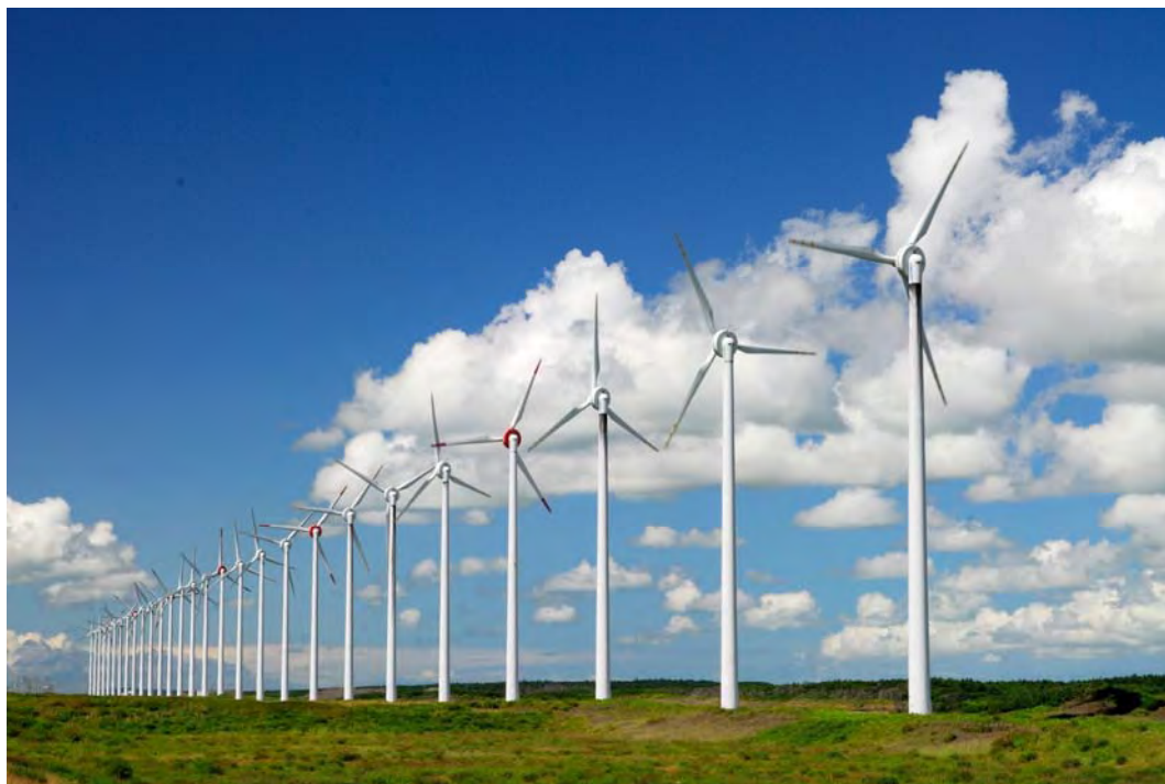
写真 オトンルイ風力発電所
