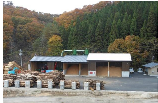
写真1 飯南木質バイオマスセンター
