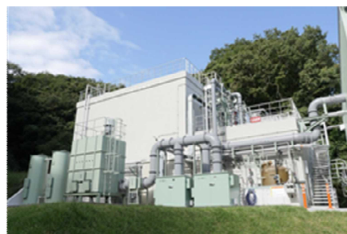
プラントの外観
