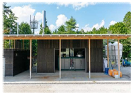
森の金太郎発電所の外観
