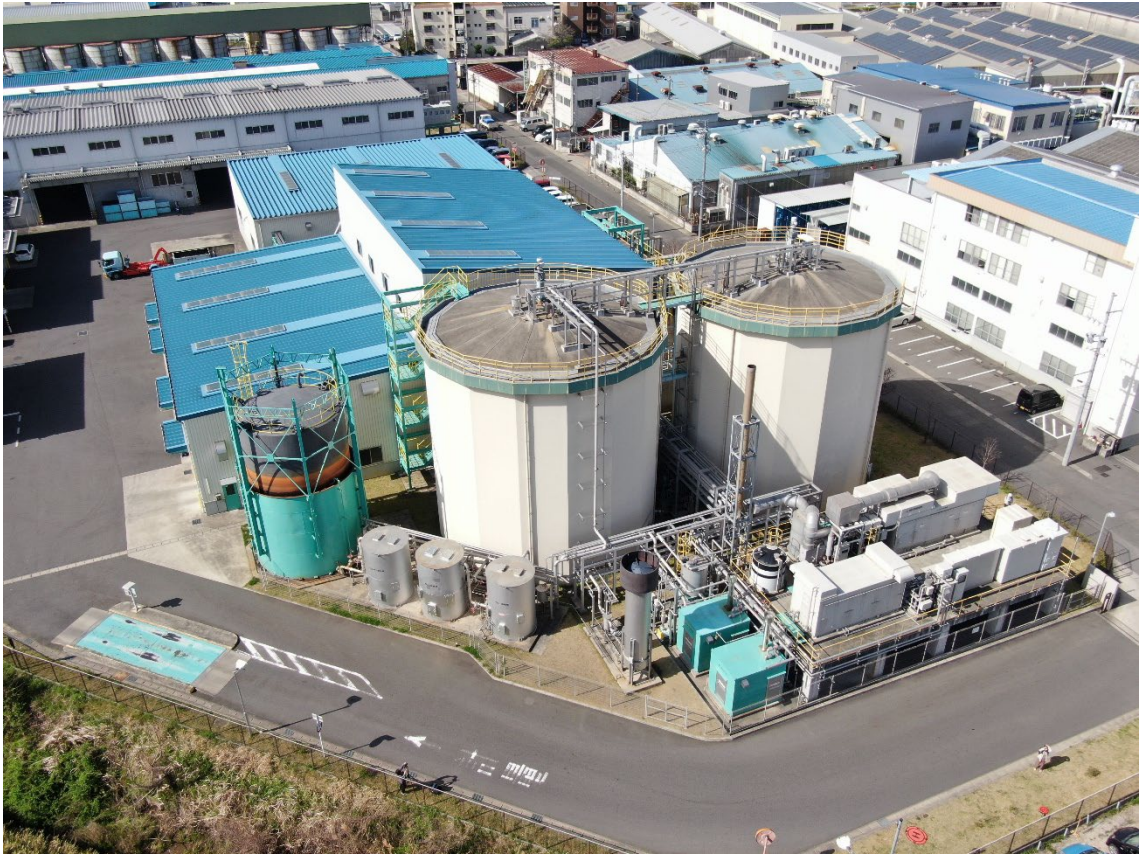
横根バイオガス発電施設（上空から）
