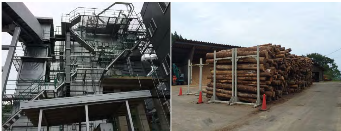
木質バイオマス発電所
