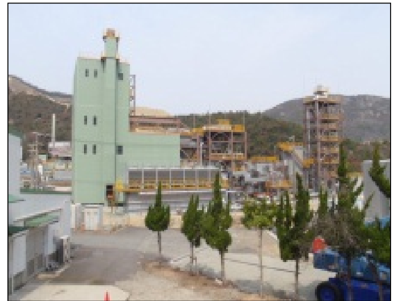
石炭燃焼試験設備（兵庫県相生市）
