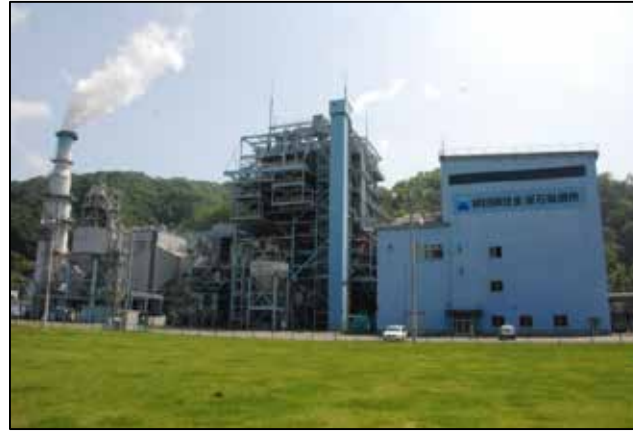
新日鐵住金釜石製鉄所エネルギー工場 149MW 石炭火力発電所
