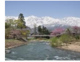
大出の吊り橋
