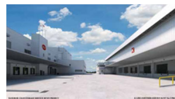
【海外の冷蔵・冷凍物流倉庫】
