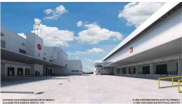
【海外の冷蔵・冷凍物流倉庫】
