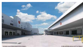
【海外の冷蔵・冷凍物流倉庫】
