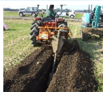
暗渠排水の整備
