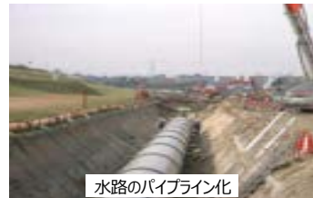
水路のパイプライン化
