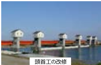
頭首工の改修
