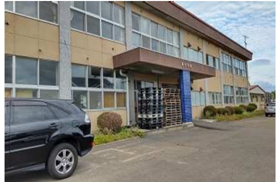
(廃校を利用した貯蔵施設)
