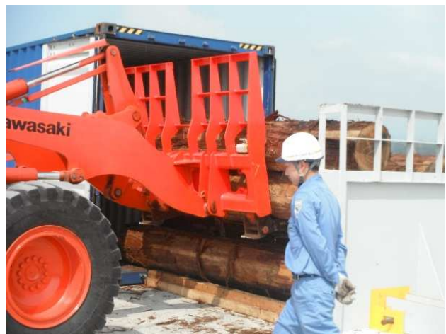
(コンテナからの搬出作業)
