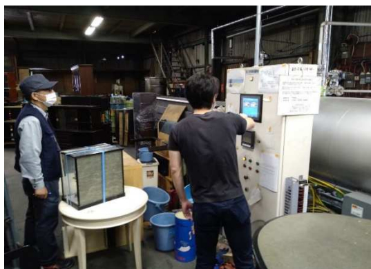
（施設調査の様子）
