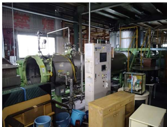
(真空加圧含浸装置)
