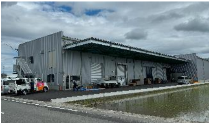
令和6年竣工 かんしょ集出荷貯蔵施設
