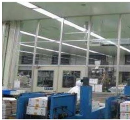
施設整備・改修 (パーティション設置)
